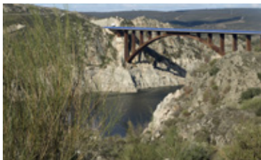
Pont sur le lac de barrage de l'Esla
